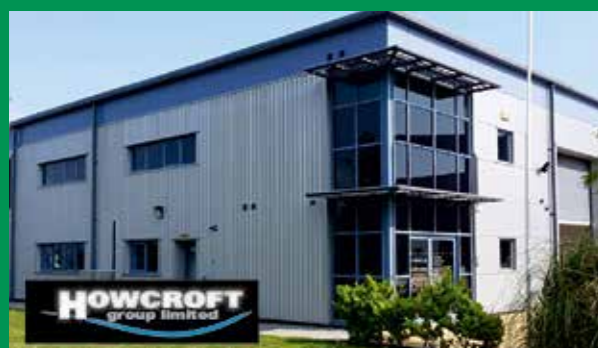
A lato la sede di Howcroft ed alcune immagini degli uffici e del magazzino.
